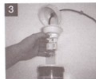
3 Desconecte a lâmpada
